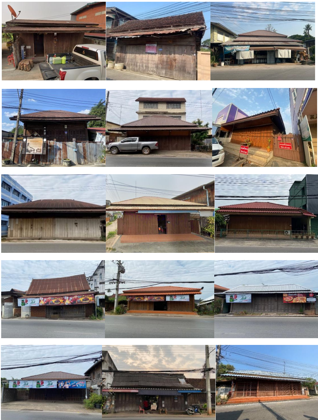
รูปที่ 4.1-2 รูปแบบเรือนไม้ชั้นเดียวหลังคาทรงปั้นหยาและทรงจั่วในย่านเมืองเก่ากำแพงเพชร
